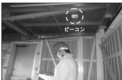
写真-2 ビーコン設置状況
