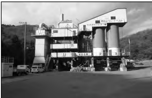
写真-1 合材工場
