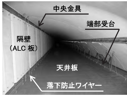
写真-2 天井板内部
