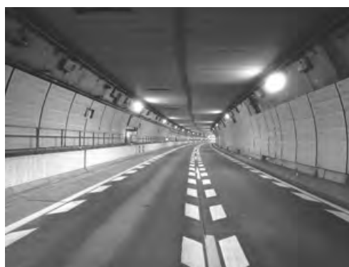
写真-1 天井板撤去前
