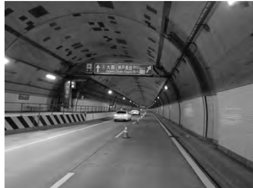
写真-10 天井板撤去完了
