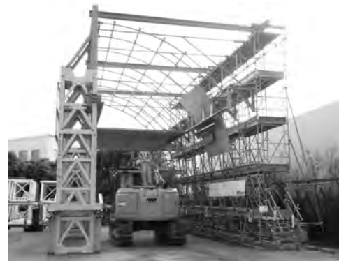
写真-4 天井板撤去実証実験設備
