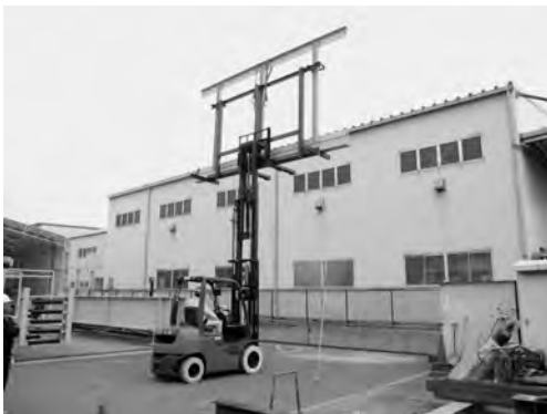
写真-9 中央金具撤去の試験施工
