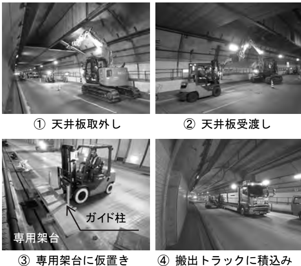
写真-6 天井板撤去作業の流れ
