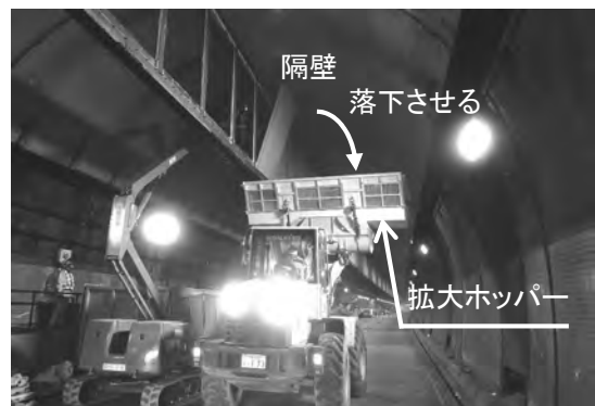
写真-7 隔壁撤去状況
