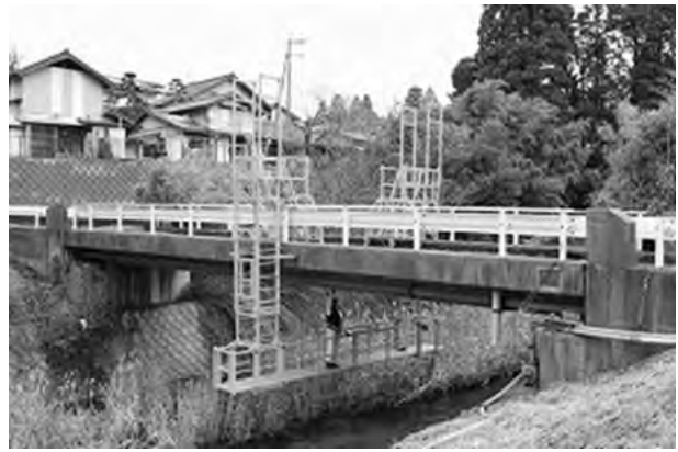
写真-1 ブリッジハンガーの設営状況
