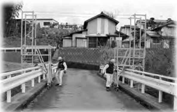
写真-4 人力による装置の移動状況
