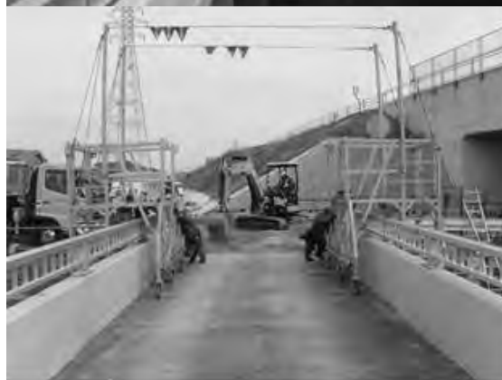
写真-6 重量規制がある橋梁での設営状況
