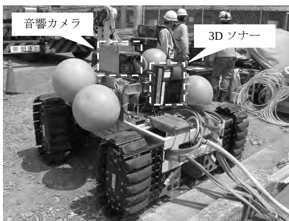
写真-7 機材搭載状況
