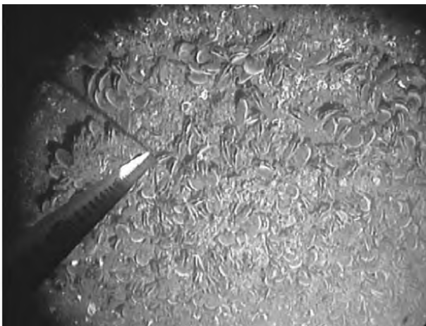
写真-12 光学式水中カメラ映像（放水路内壁面）
