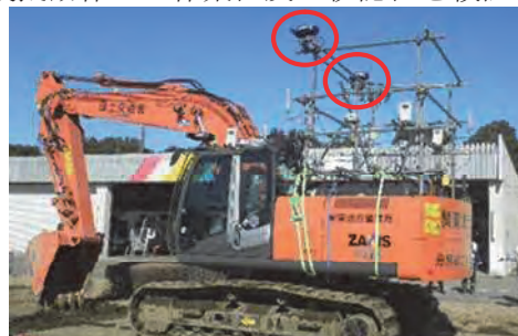
写真-2 仮説取付架台
