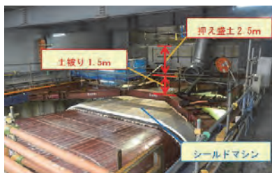
写真-2 シールド機発進状況
