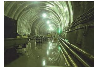
写真-2 坑底部緊急排水状況
