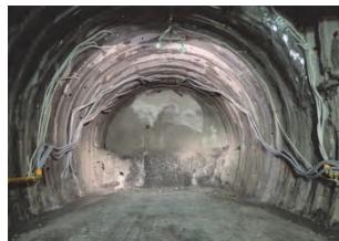
写真-5 切羽湧水導水状況
