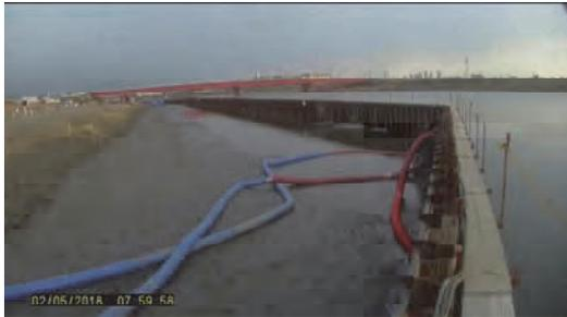
図11 水替えにより水位低下の臨場
