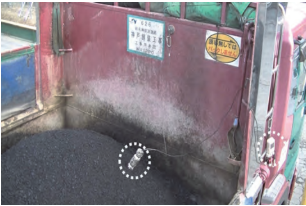
写真-7 Wi-Fi 温度ロガー設置状況
