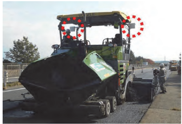
写真-9 Wi-Fi 装置取付け状況
