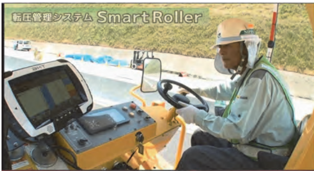
写真-12 クラウド型転圧管理システム取付け状況
