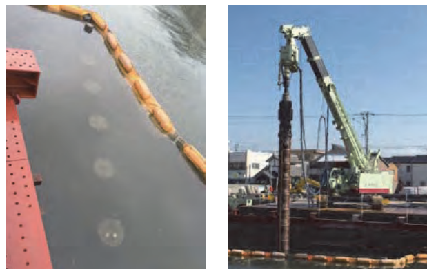
図-8 水中に杭頭がある際の引抜き
