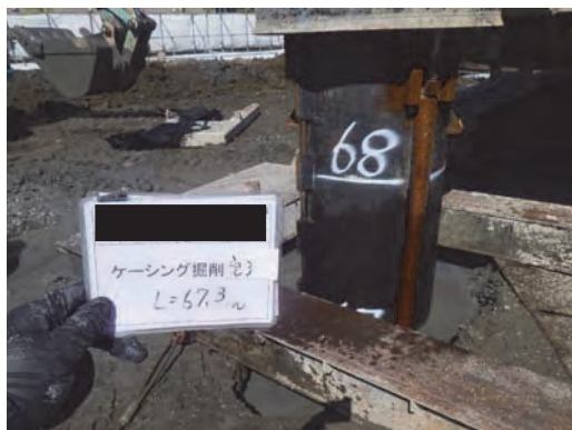
図-9 新設杭干渉部での引抜き (67m)
