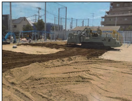
写真-8 狭隘な箇所の施工
