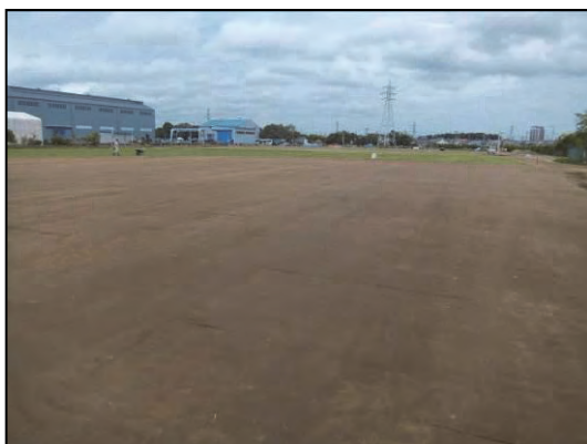
写真-10 改良後の状態
