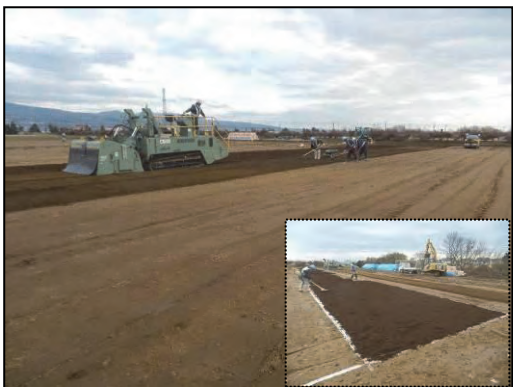
写真-7 攪拌改良～仮転圧まで
