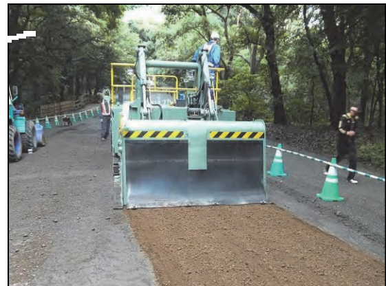
写真-5 改良前・後の状態
