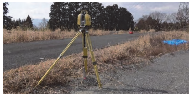
写-3 地上型レーザースキャナ計測状況
