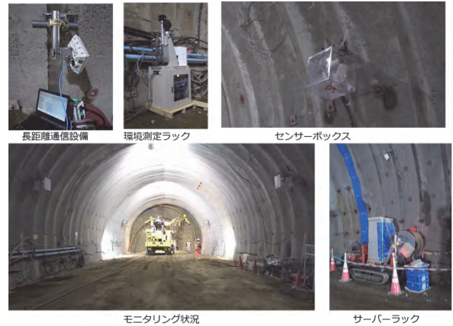
写真-1 位置・移動把握技術の検証状況
