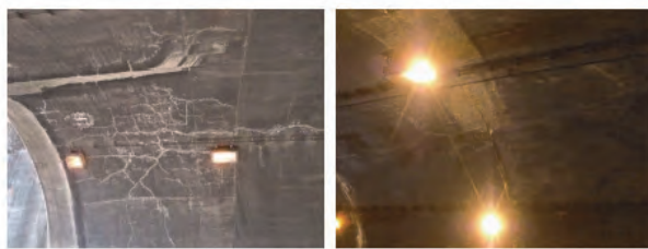
坑口付近のスパン
