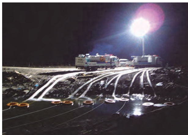
写真－2 夜間排水状況 1)
