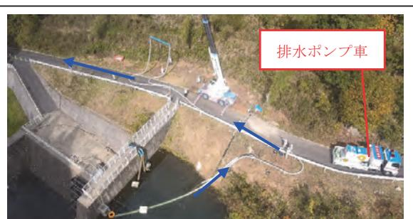
図-9 「災害対策用排水ポンプ車」と「ハイブリッド・S」の組み合わせによる実験状況
