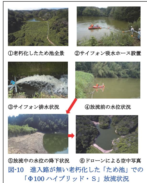
図-10 進入路が無い老朽化した「ため池」でのΦ100ハイブリッド・S放流状況
