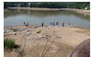
写真-4 排水作業進捗時
