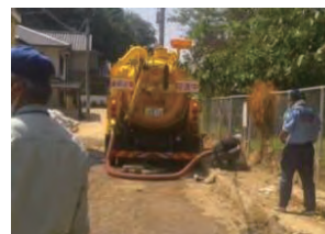
写真-9 排水管清掃作業(水循環式) (広島県安芸郡坂町)
