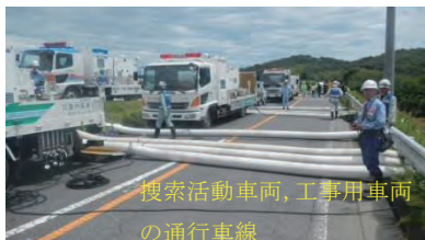
写真-2 小田川での排水作業状況
