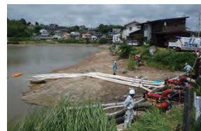
写真-3 排水作業開始時
