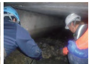
写真-9 排水管清掃作業(水循環式) (広島県安芸郡坂町)
