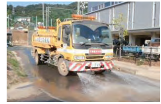
写真-5 散水車による散水作業状況
