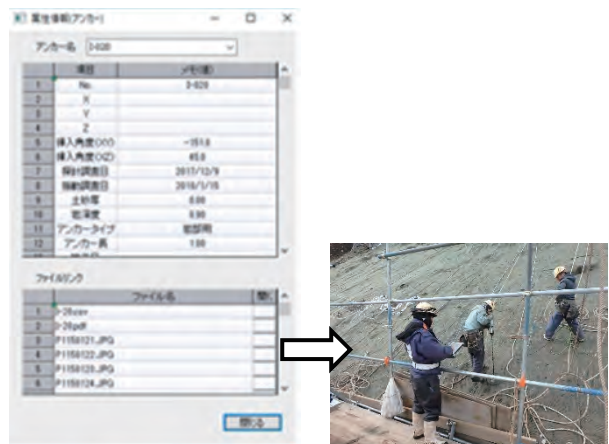
図-4 属性情報および施工写真表示例
