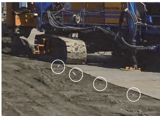
写真-1 目杭設置状況
