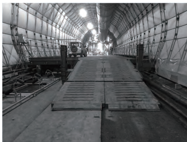
写真-5 スライディングステージ設置状況
