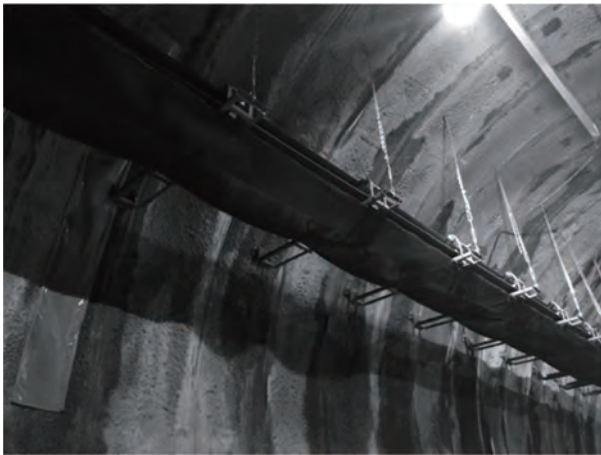
写真-6 ブラケットフレーム追加状況
