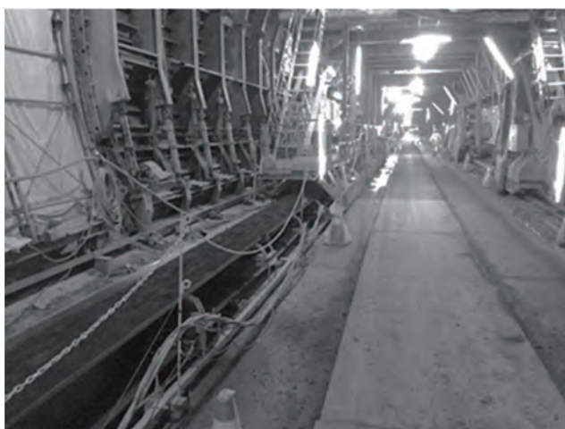
写真-4 セントル部ベルコン下通過状況
