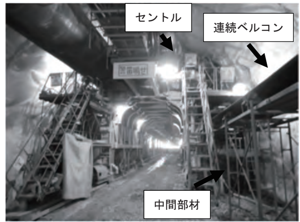
写真-1 セントル部ベルコン通過状況
