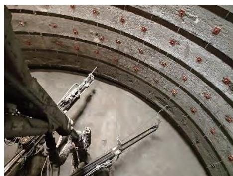
写真-4 ロックボルト挿入状況
