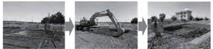
図4 現場の作業の様子
