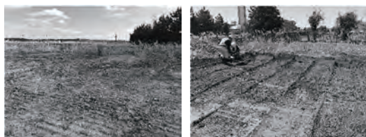
図3 整形作業前(左)と作業後(右)の現場
