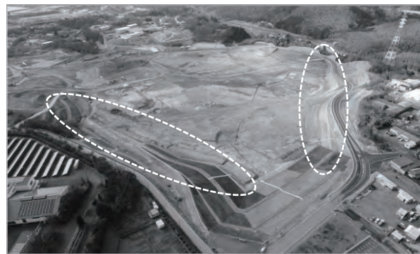
写真-1 土岐口開発造成 現場試行箇所
