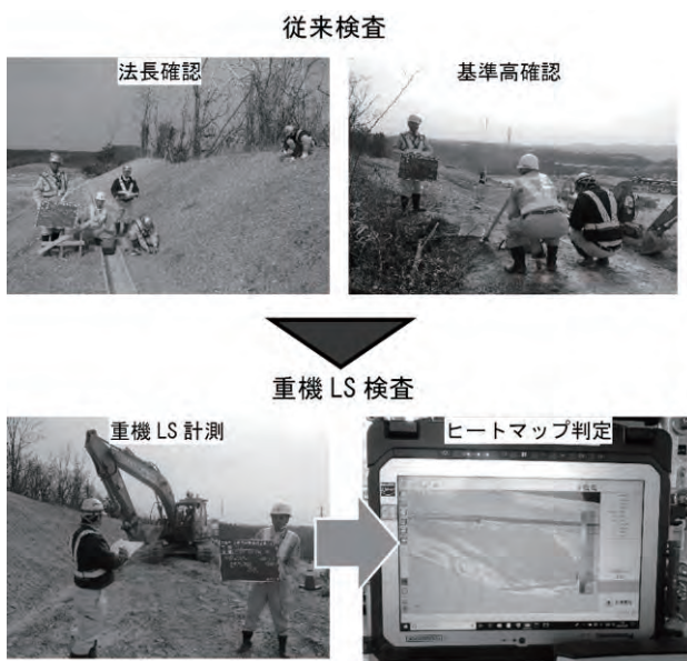
写真-5 従来検査と重機LSでの検査状況
