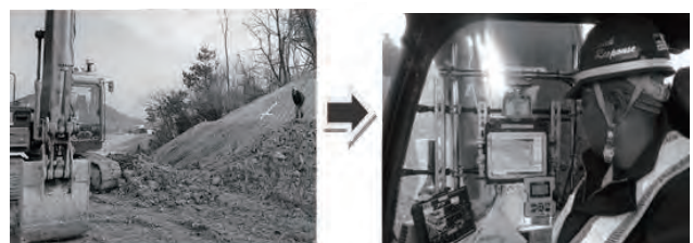
写真-4 従来と重機 LS での出来形確認状況
