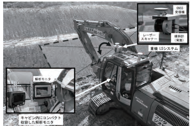
図-1 重機 LS の計測状況とシステム構成
