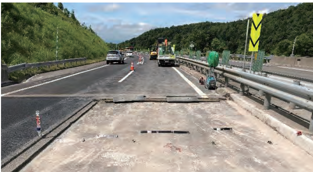
写真-5 現場試用状況 (ターゲット配置)
