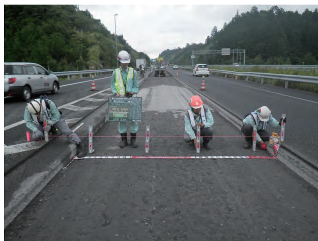
写真-1 水系下がり検測状況
