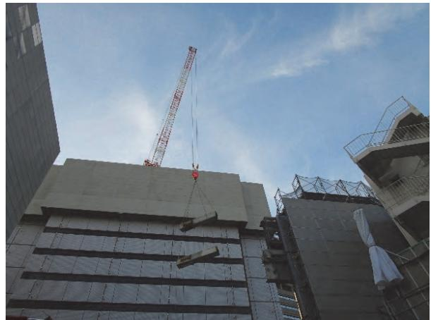
FCF 搭載足場の降下作業は解体作業の進捗に合わせて 1 フロアごとに行なった。安全対策として足場の層ごとに層間養生対策を行い、降下作業中は端部での作業を行わないことを徹底した。降下作業手順を次に示す。
