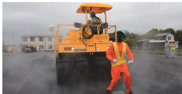
写真-1 実際の試験施工
