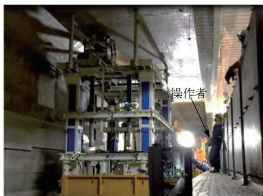
写真-7 研掃装置による施工状況
