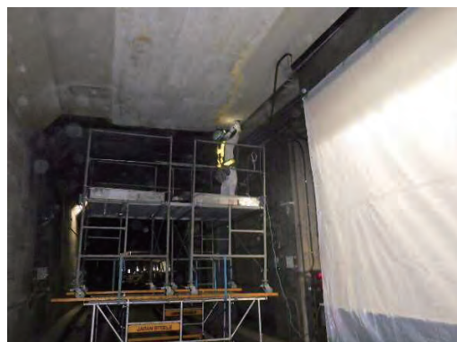
写真-8 人力による施工状況
