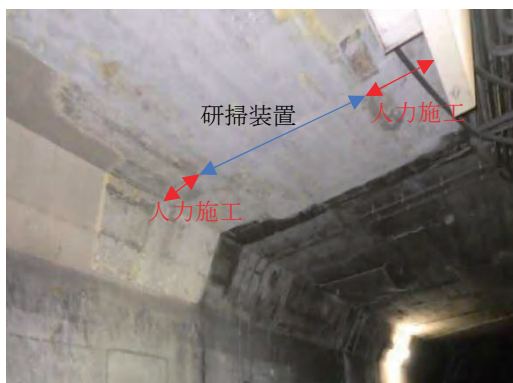
写真-10 研掃による仕上がり面の状況（下り線）
