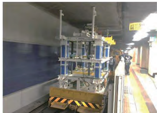
写真-16 上り線施工状況
