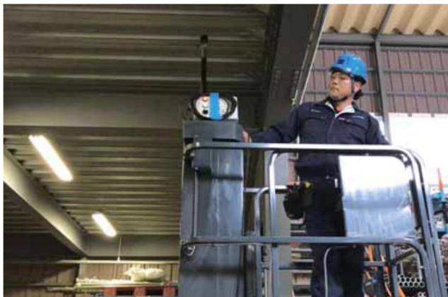
写真-2 (設置状況)
