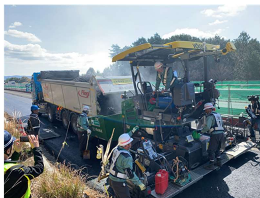
写真2. 荷下ろし状況
