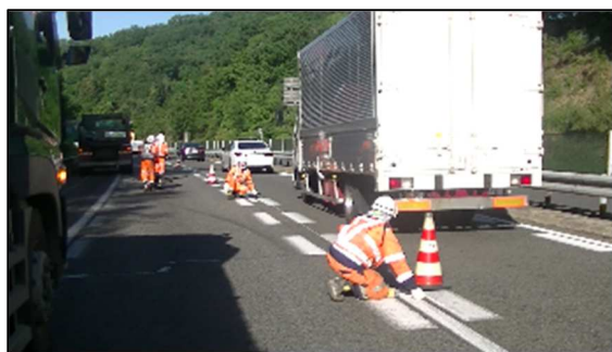
写真-1 従来の通り出し作業状況
