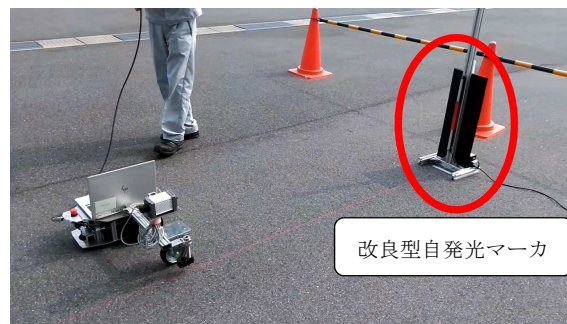
写真-8 改良型自発光マークによるマーキング試験状況
