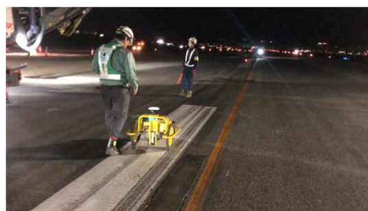
写真-3 現場試用状況写真
