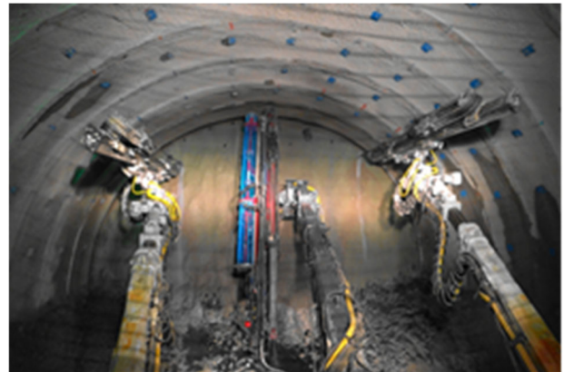
図-17 改良後のユニットの施工状況 (左右：穿孔ブーム, 中央：ロックボルトブーム)
