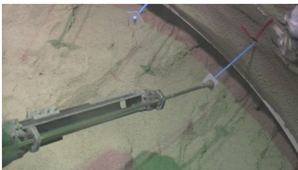
図-3 ロックボルト挿入状況
