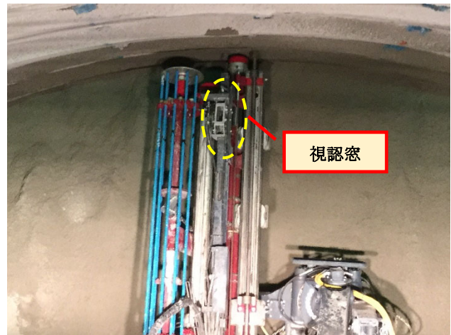
図-15 モルタルホース視認窓増設
