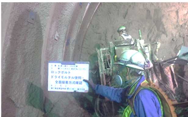
図-2 定着モルタル注入作業
