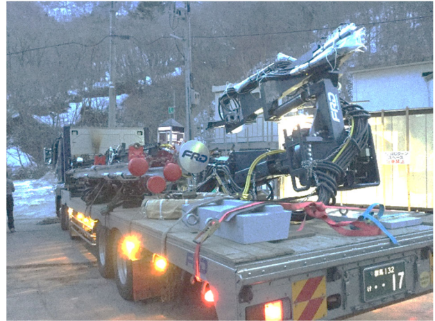
図-9 ロックボルト用ブーム搬入状況
