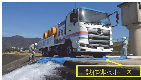
写真1 現地試験状況
