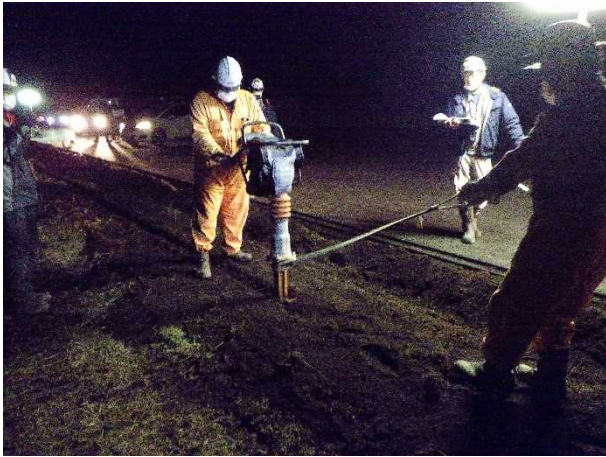
写真-7 ランマの締固め状況
