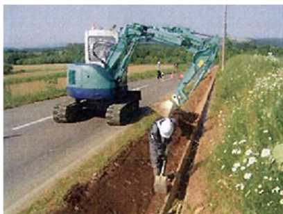
写真-1 バックホウによる掘削
