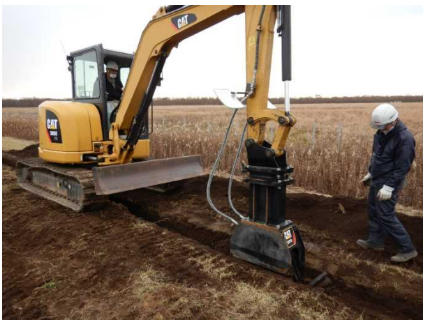
写真-8 バックホウ用アタッチメント型振動コンパクタの締固め状況
