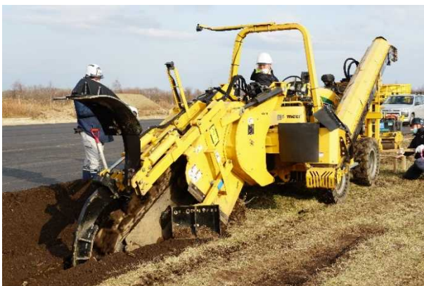
写真-3 トレンチャーの掘削状況
