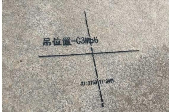
写真-5 3回連続墨出し後の印字面
