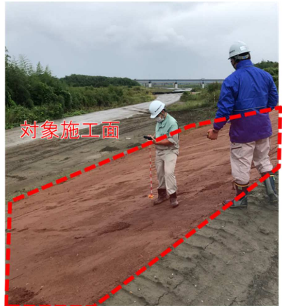
写真-3 TS 計測状況試験状況
