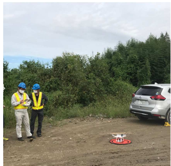
写真-4 UAV 計測状況
