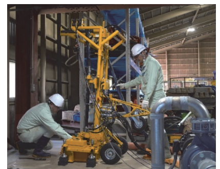
図-3 建屋内高さ制限下での施工
