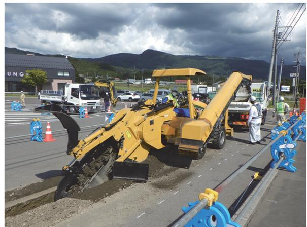
写真-2 トレンチャーによる施工状況
