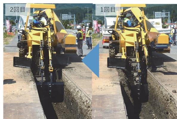
写真-5 トレンチャーでの掘削状況
