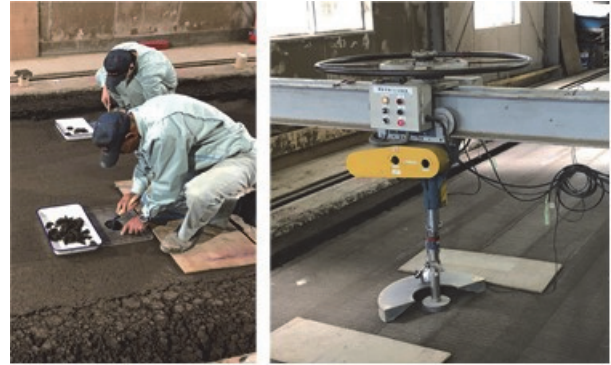
写真-2 測定状況 (左: 砂置換法, 右: CBR)
