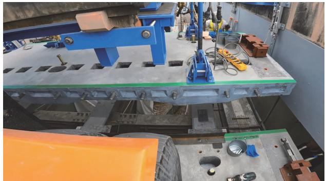
写真-7 PS ジョイント床版架設開始
