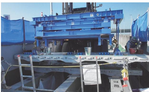
写真-6 PS ジョイント床版運搬状況
