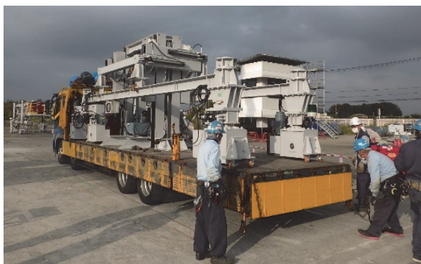
写真-1 架設機走行フレーム運搬
