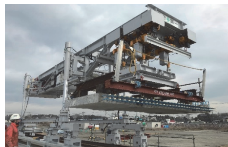
写真-6 床版架設機での床版架設状況
