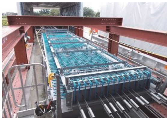
写真-14 床版製作状況
