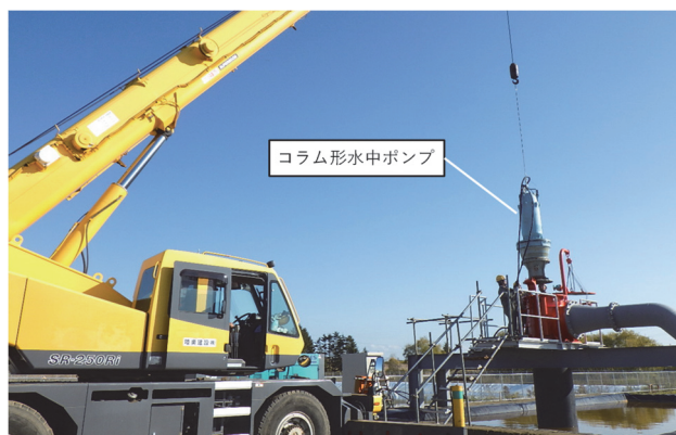
写真-2 コラム形水中ポンプ設置状況
