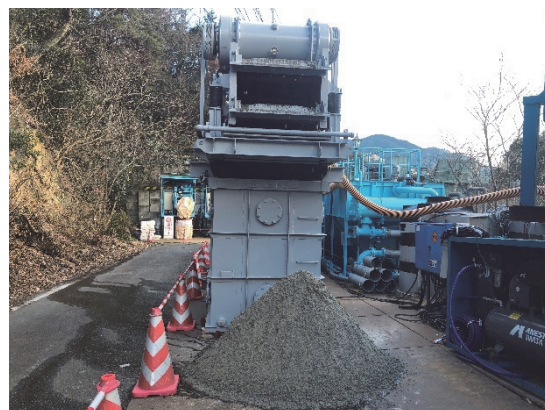
写真-8 陸上ヤード 砂回収状況
