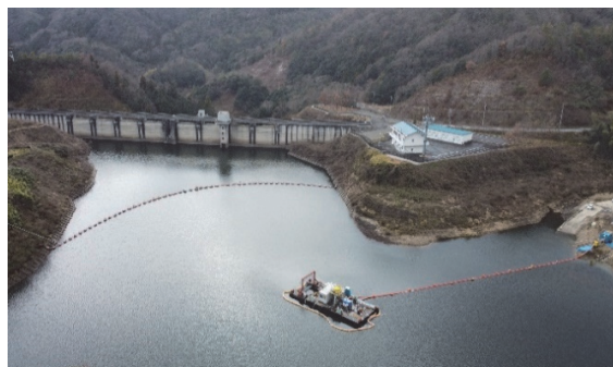
写真-1 ダム湖における試験施工
