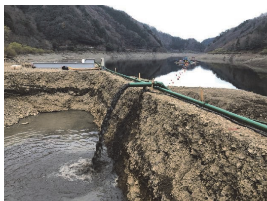
写真-7 湖岸沈砂池
