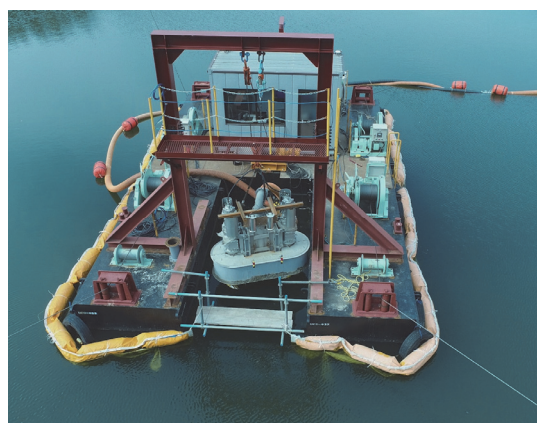
写真-2 作業台船全景
