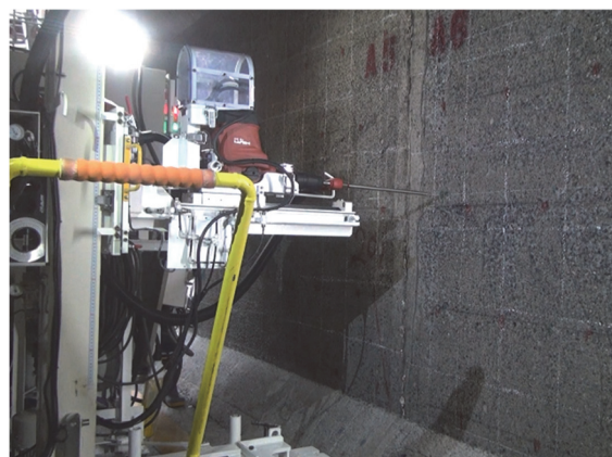
写真-5 自動削孔装置の自動削孔状況
