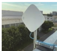
写真-2 アンテナ設置状況 (B 棟)
