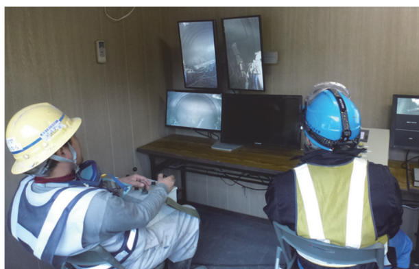
写真-1 遠隔吹付風景
