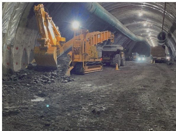
写真-9 トンネル坑内運用状況(前方)
