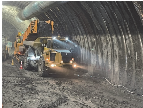
写真-8 トンネル坑内運用状況(後方)
