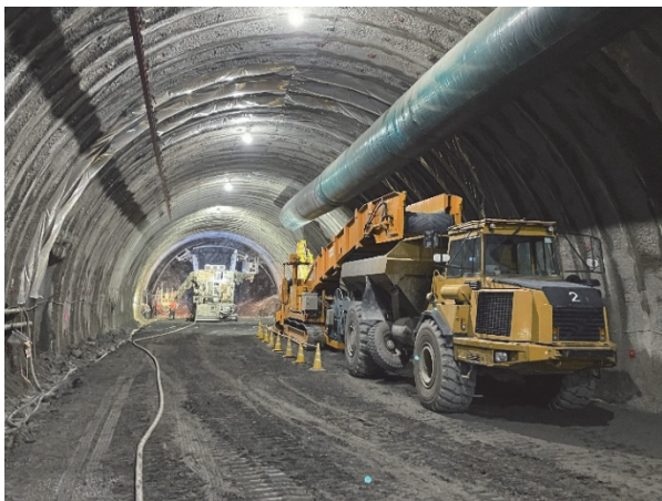
写真-10 切羽の早期解放状況
