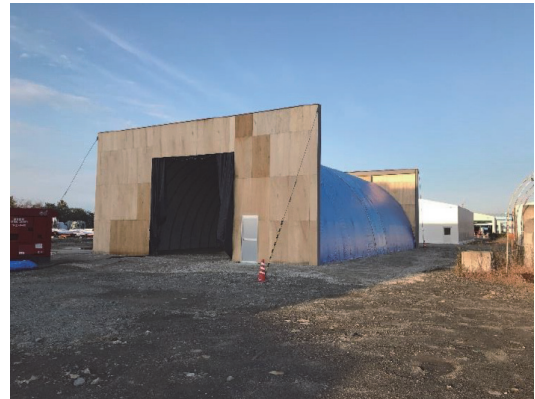
写真-4 模擬トンネル
