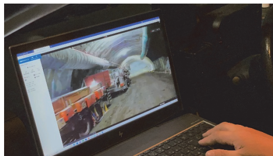
図-10 PCによる坑内ドローン点検リアルタイム確認
