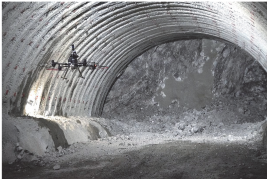
図-6 切羽認識による自律飛行停止
