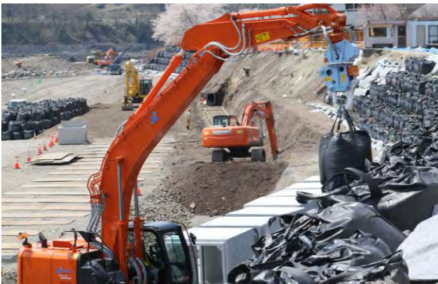
図 1: 災害復旧現場での大型土のう設置工
