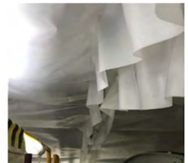
写真2 シートの溶着箇所
