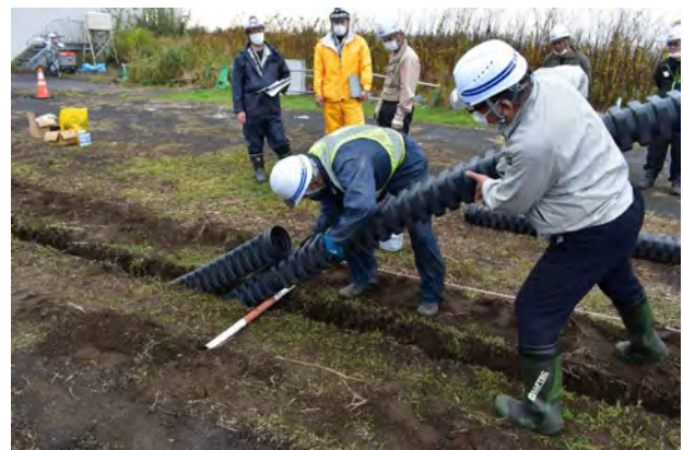
写真-3 管路材接続状況
