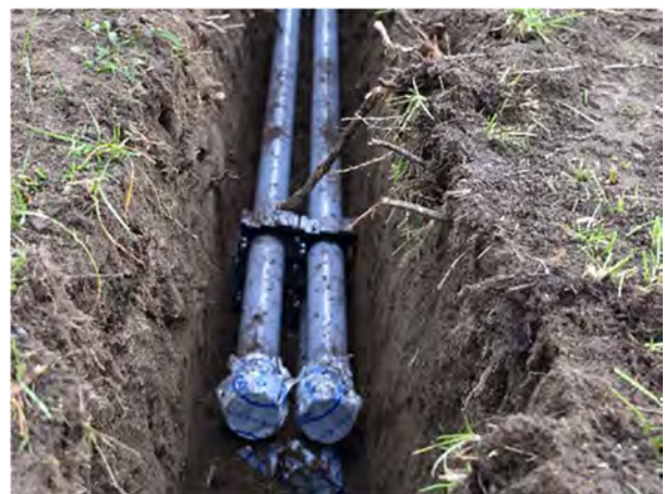
写真-6 管路敷設状況
