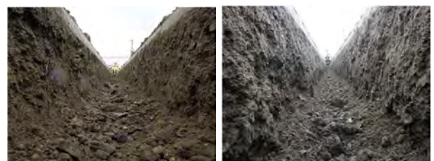
写真-8 掘削断面仕上り状況
