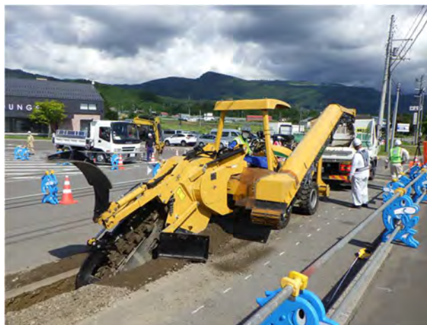
写真-1 トレンチャーによる施工
