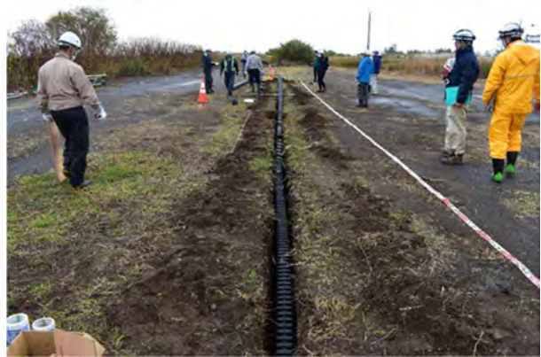
写真-4 管路敷設状況
