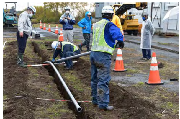
写真-5 管路接続状況
